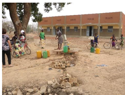
Unterrichtsgebäude mit Schulbrunnen
