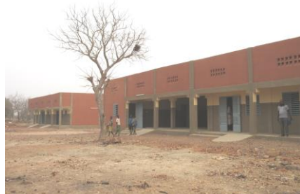
Unterrichtsgebäude (l.) & Werkstätten (r.)
