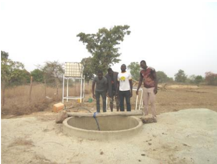
Schöpfbrunnen mit Solarpumpe
